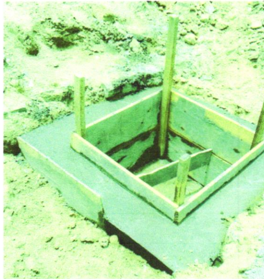
Foto 09 - CONCRETO FCK = 25MPA, TRACO 1:2,3:2,7 (EM MASSA SECA DE CIMENTO/ AREIA MÉDIA/ BRITA
