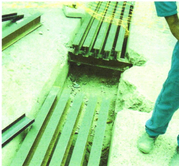
Foto 18 - FORNECIMENTO E ASSENTAMENTO DE GRELHA DE (0,30 X 0,60 M)
