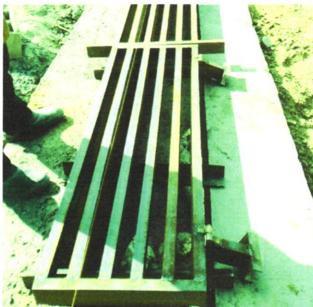
Foto 17 - FORNECIMENTO E ASSENTAMENTO DE GRELHA DE (0,30 X 0,60 M)
