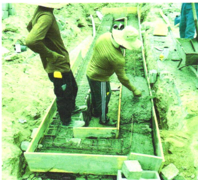
FOTO 4 - FABRICAÇÃO, MONTAGEM E DESMONTAGEM DE FORMA PARA RADIER, PISO DE CONCRETO OU LAJE SOBRE SOLO, EM MADEIRA SERRADA, 4 UTILIZAÇÕES. AF 06/2021
